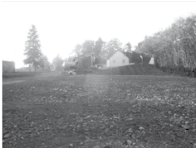
Début des travaux de réalisation du parking Rue du Bélier.
