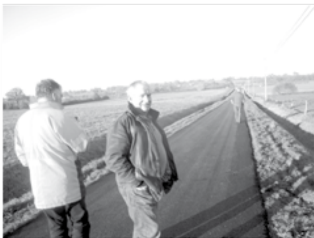
Modernisation de la VC 116 du Haut Rochereuil à la route de La Bosse.
